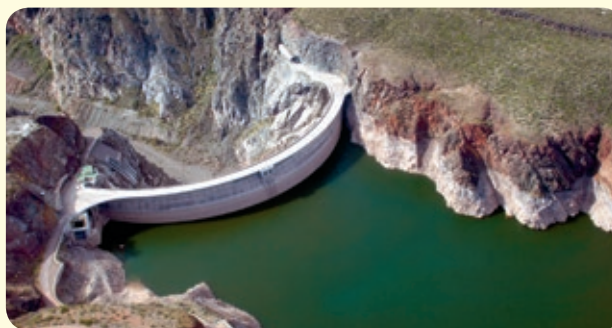
Desvío de los cursos de agua. Las personas les dan diversos usos al agua de los ríos: consumo, riego agrícola y producción de energía, entre otros. Para eso, muchas veces construyen represas o alteran el curso de los ríos.
